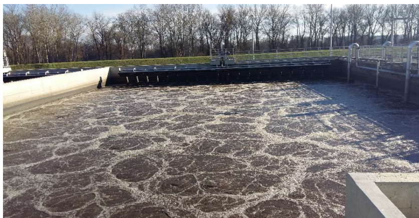
Slika 5. SBR reaktor u ciklusu aeracije Fig. 5. SBR reactor in aeration-phase
