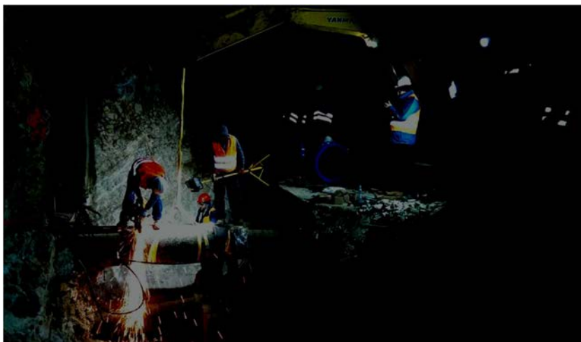
Slika 5. Građevinski radovi na izgradnji uređaja za preradu vode za piće grada Dubrovnika
