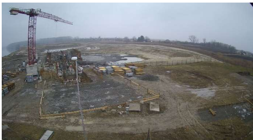
Slika 9. Druga faza izgradnje UPOV-a grada Osijeka (Vodovod-Osijek d.o.o., 2017)
